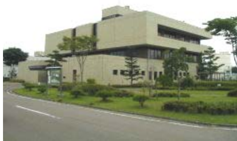
県南浄化センター管理棟
