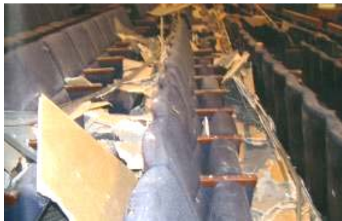
大ホール天井材の一部落下
