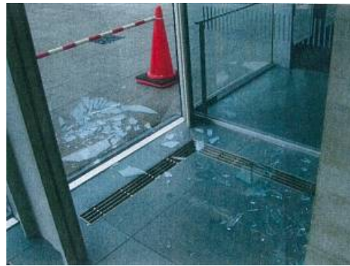
メインエントランス横ガラス破損
