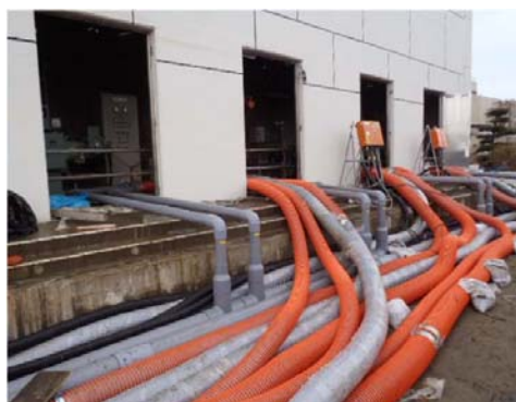
仮沈殿池への仮設ポンプによる送水
