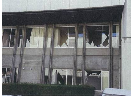
窓ガラスの破損
