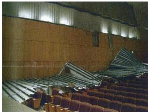
中ホール内壁上部の落下
