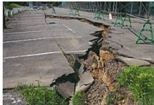
総合体育館（駐車場亀裂陥没）
