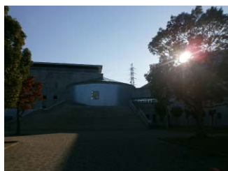
総合体育館外観
