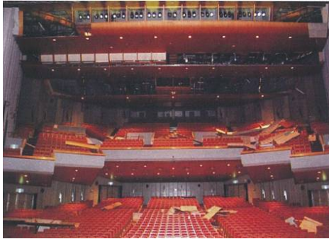
大ホールの天井崩落
