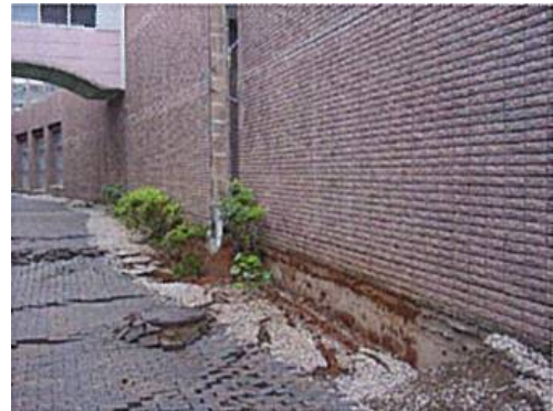
アクアパーク（大壁亀裂傾斜）
