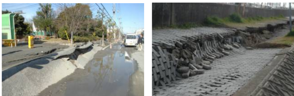
液状化被害の様子
