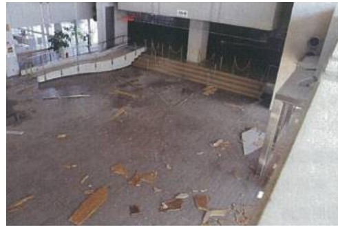
玄関ホールの被害状況
