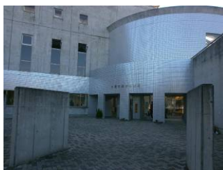
第1体育館入口
