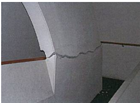
総合体育館（エントランススロープ壁亀裂）
