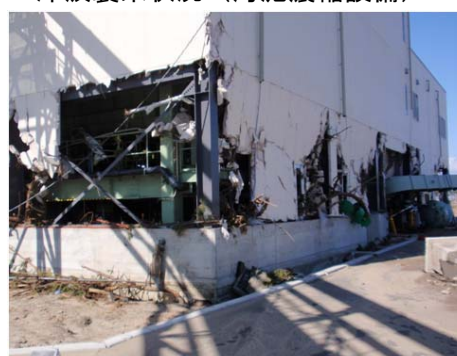
汚泥燃料化施設損壊
