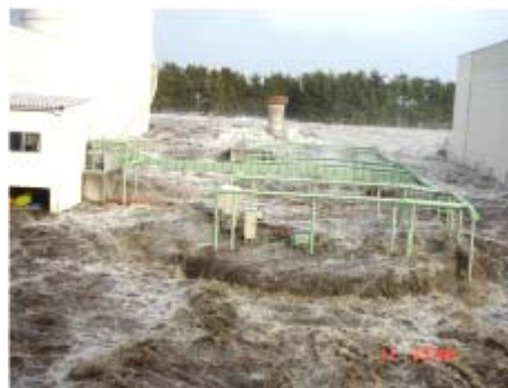
津波襲来状況（汚泥濃縮設備）
