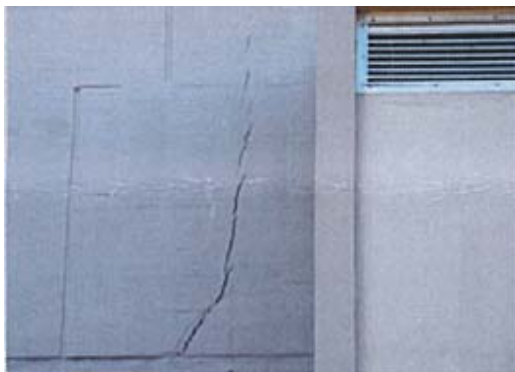
市民会館（舞台建屋の外壁亀裂）
