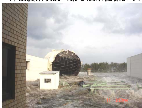
津波襲来状況（ガスタンク転倒）
