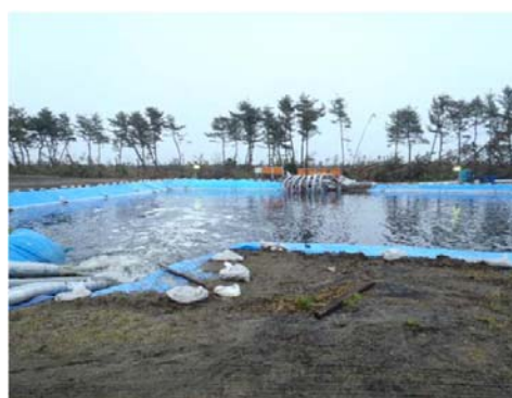
仮沈殿池設置状況
