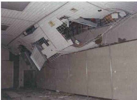
3階展示室の破損
